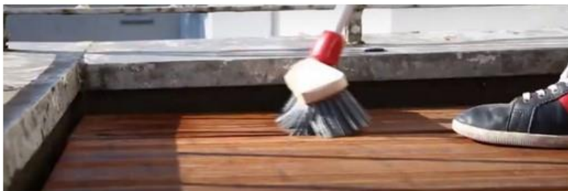
mit aMbooo Besenkopf Verschmutzungen und Aufrauhungen entfernen.
